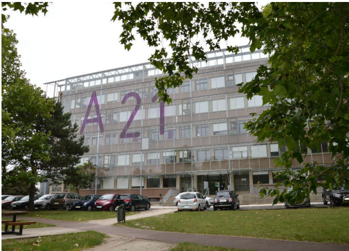
DLLC au 2ème étage du bâtiment A21.
