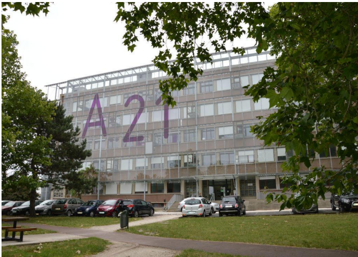
DLLC au 2ème étage du bâtiment A21.
